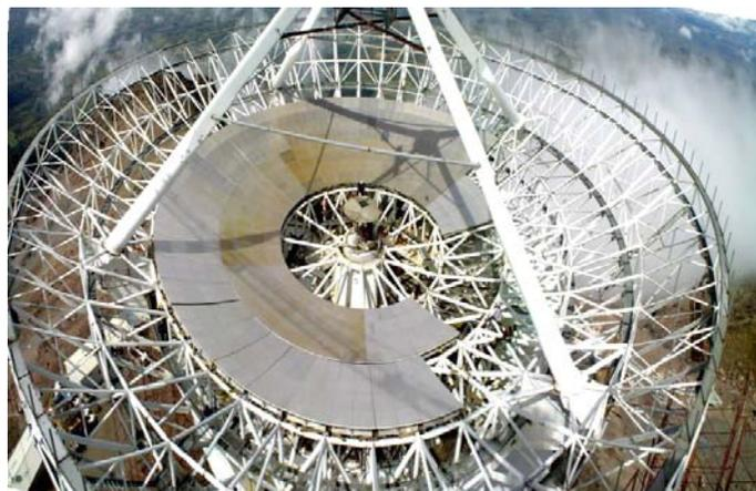
Los paneles de los anillos 2 y 3, en proceso de montaje y alineación.
