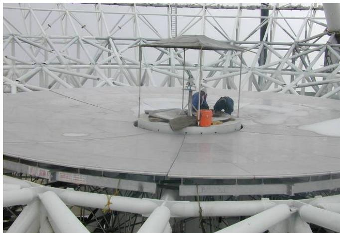
En mayo se completó la preinstalación de los paneles del anillo 1, como parte del proceso de aprendizaje del montaje definitivo.
