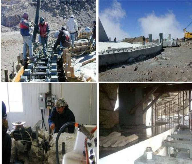
Arriba, a la izquierda, el proceso de construcción de los durmientes de la pista de rodamiento. A la derecha, el sistema de soporte terminado. Abajo, a la izquierda, el proceso de soldadura del riel. A la derecha, la pista terminada.
