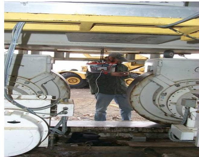
*La instalación y alineación del sistema de rodamiento azimutal.*
